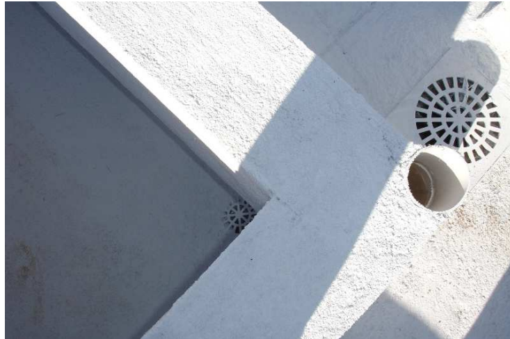
FIGURA 7: Instalação de ralos como filtro FONTE: Silveira (2007)
