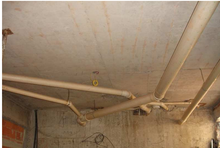
FIGURA 8: Tubulação na laje FONTE: Silveira (2007)
