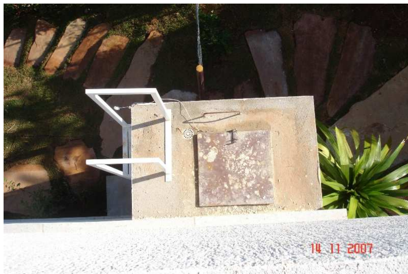
FIGURA 10: Alçapão para inspeção do reservatório FONTE: Silveira,2007
