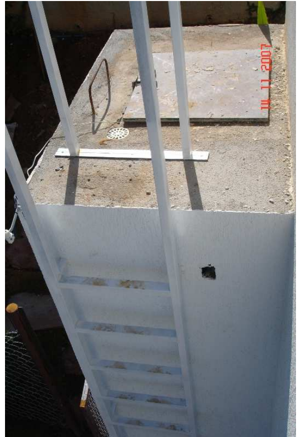
FIGURA 9: Acesso ao reservatório inferior FONTE: Silveira,2007
